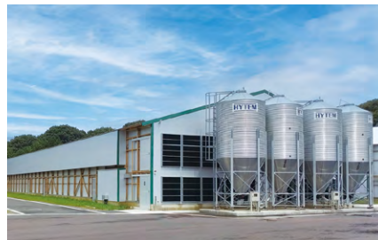
新設された「育成舎」
